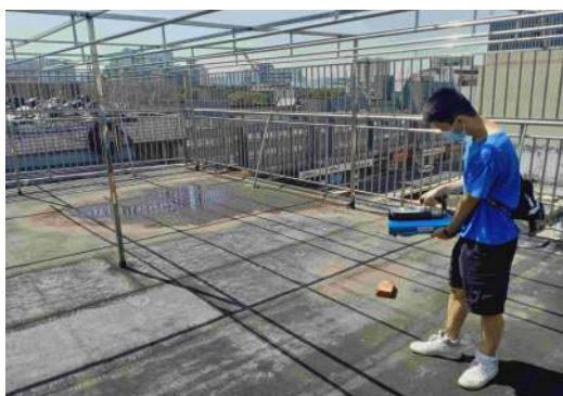
图 3-9 3 号手术室正上方住院楼楼顶
